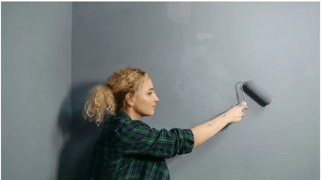
Pintura de acabado, última fase de la obra
