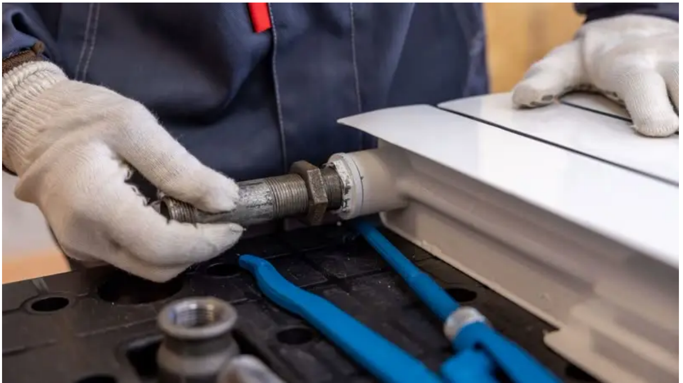
Montaje de la instalación de fontanería
